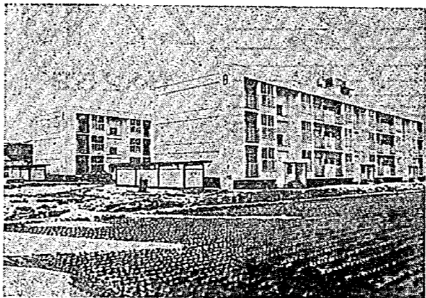
完成も近い町営住宅
