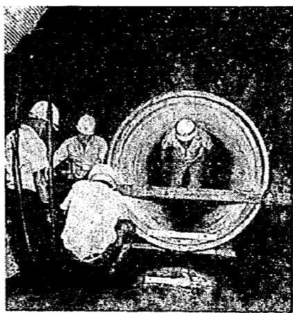
流域下水道新潟幹線きよに接続
