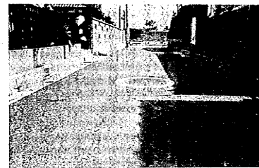
枝線工事も完了整備された中島3丁目
