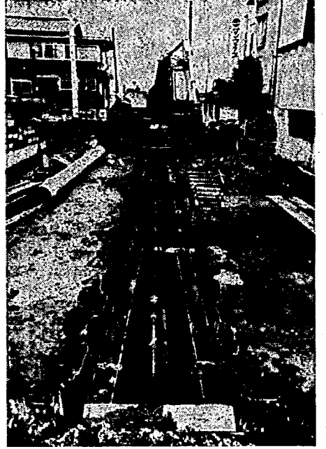
下水道の枝線工事(中島3丁目)
