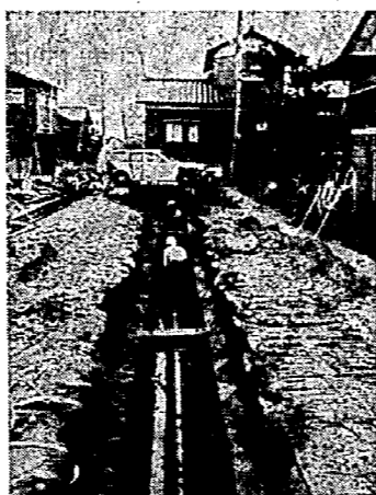
管きよ布設工事
