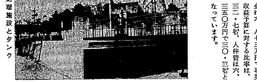
排水処理施設とタンク
