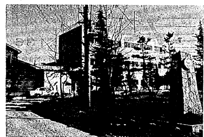
東側校舎木造平家建を鉄筋コンクリート造りに改築 (亀中正面)
