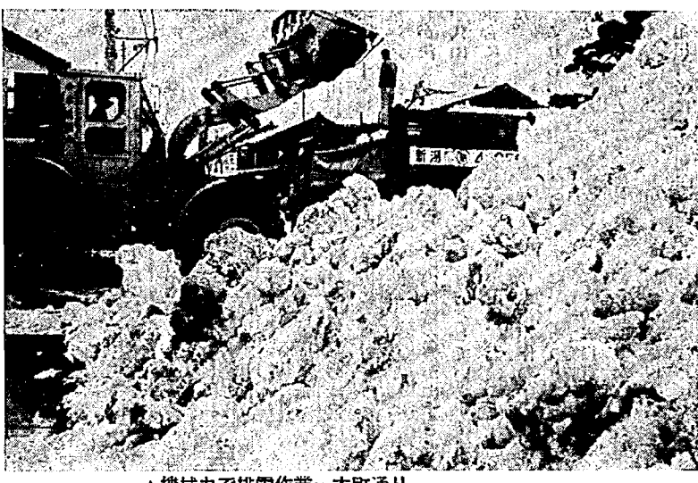
▲機械力で排雪作業…本町通り
