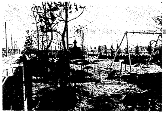
工事施工中の本町4番目の中島児童公園
