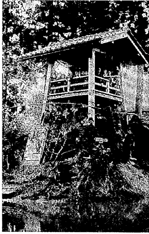
大正6年10月信濃川堤防の破壊 早通宗通寺かねつき堂へ避難する住民
