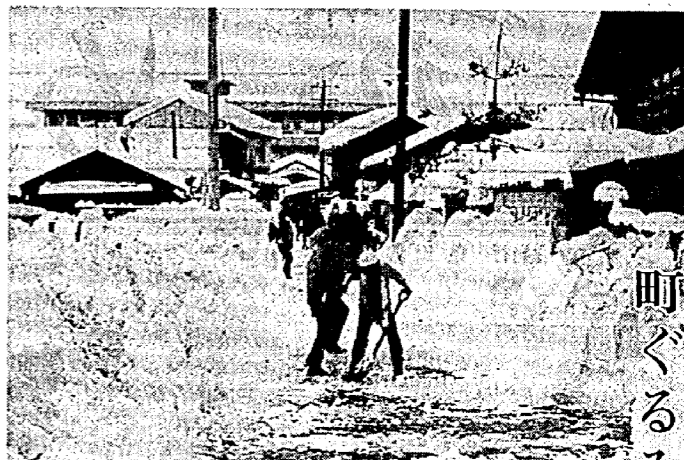
44年1月の豪雪、町内一斉で除雪作業 (新明町1丁目地内)
