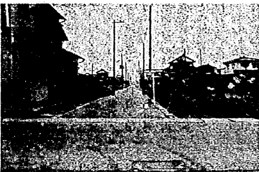
西町地内町道172号線舗装工事 延長372m 幅5.5m 金額620万円
