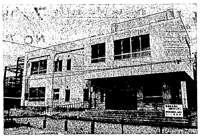
外部給排水工事を残しすっかりできあがった老人福祉センター
