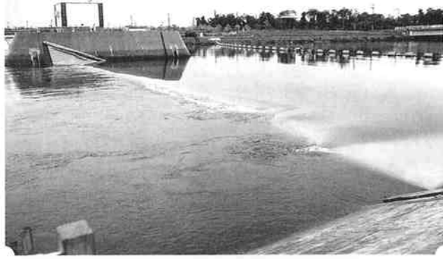
7月13日(火)、中下越を襲った豪雨で、福島潟放水路の2つのゴム堰(せき)が開けられました。豊栄市民の悲願であった放水路が初めて稼(か)働。
