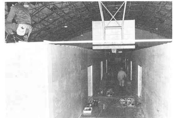
▲体育館に急ピッチで作られる臨時教室 (26日午後2時)
