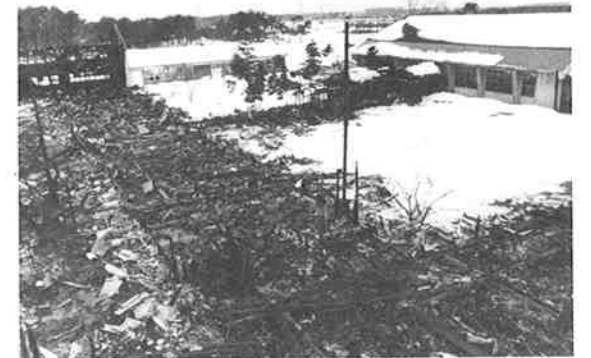
▲焼け残った体育館と金工室、木工室 (24日午前11時)
