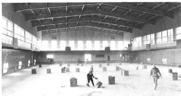
建築中の体育館
