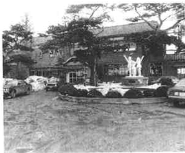
校舎が建設される岡方第二小学校
