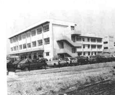
体育館、プールが建設される早通中学校
