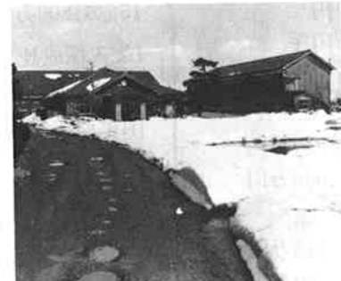
校舎が建設される岡方第一小学校
