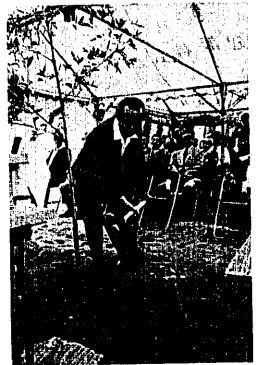
笹山小学校校舎建築が正式に始まり、起工式でくわ入れる市長。(7月4日 現地にて)
