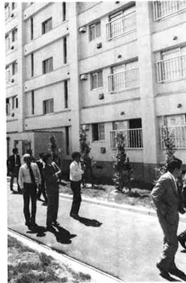
▲全国の公営住宅建設事業担当者が早通北の県営アパートを視察しました。（6月3日）
