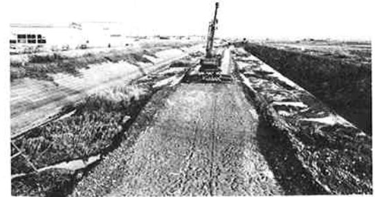
△ 放水路の中央に道路が？ 胡桃山導水路の改築工事が行われています。川底を掘り下げる工事に鋼矢板を打ちますが、兩岸からは不可能なため仮設の道路がつくられています。
