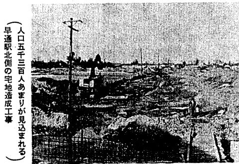
早通北側の宅地造成工事
