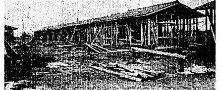
(建築工事中の分譲住宅)
