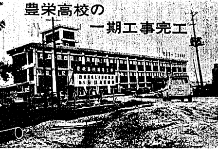
豊栄高校の一期工事完工
