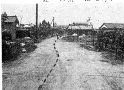
(写真 白新町の一部、点線の部分に下水路を布設)
