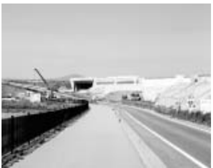
4車線化工事が進む東バイパス
