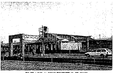
整備が進む新津駅東西歩行者道
