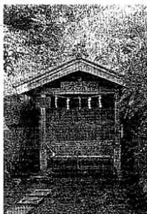
寺用として利用されていた頃の清水は、今よりも小規模な湧水であつたと思われますが、住民用として利用されるようになってからは、留水分部を拡張して周囲を石垣で囲み、雨水を防ぐために屋根を設置するなどの、様々な改良が施されてきました。
