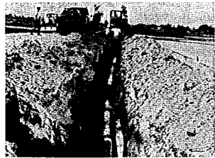
減圧解消のため配水管を布設しています
