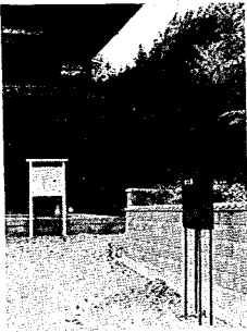
妙蓮寺山門脇に消火器を設置
