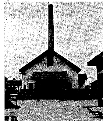
老朽化した斎場を新築します
