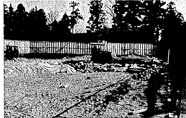
大関の廃棄物埋立地に築堤工事や汚水処理設備工事をを行います
