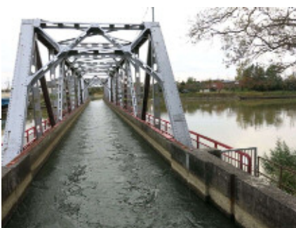
西川・新川立体交差
